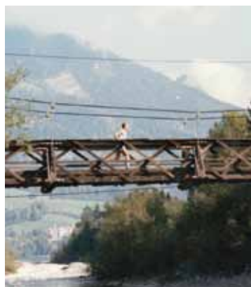
Km 16 – die malerische Zinkenbachbrücke.
